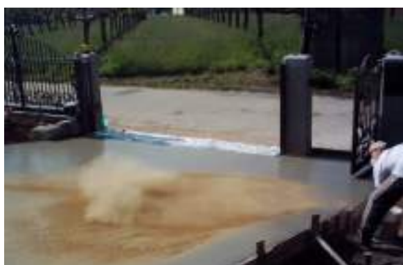
Si procede nelle operazioni di spolvero con l'indurente corazzante nella colorazione prescelta
