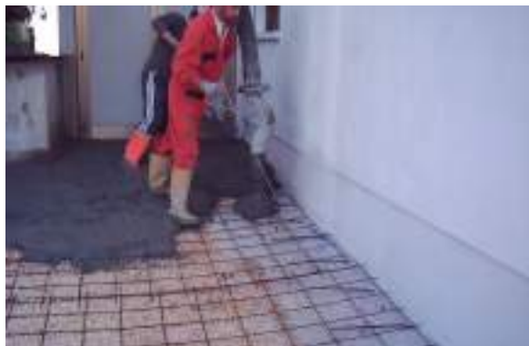
Stesura del calcestruzzo sul fondo ben compatto
