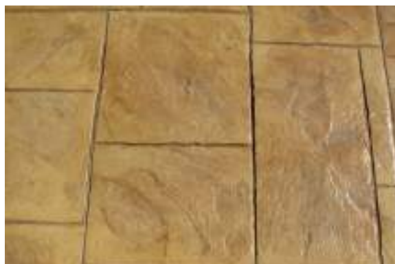
Per ultimo viene effettuato un trattamento con resina acrilica antiolio, che ne conferisce brillantezza e durata
