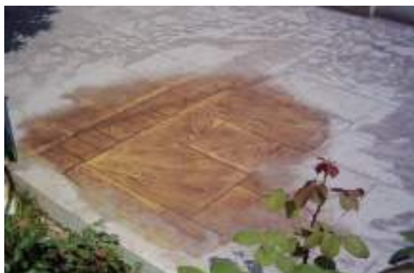
A maturazione del pavimento sarà sufficiente lavare accuratamente con l'idropulitrice
