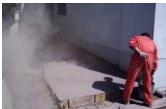
Viene quindi effettuato lo spolvero del distaccante che consente di fornire una colorazione variegata
