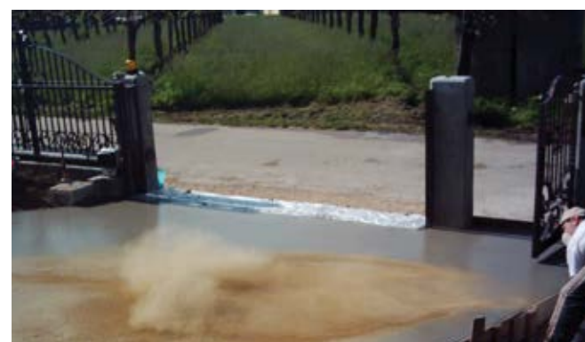
Si procede nelle operazioni di spolvero con l'indurente corazzante nella colorazione prescelta
