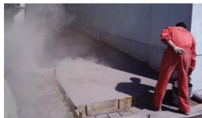
Viene quindi effettuato lo spolvero del distaccante che consente di fornire una colorazione variegata
