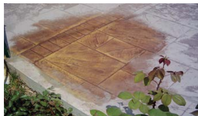
A maturazione del pavimento sarà sufficiente lavare accuratamente con l'idropulitrice
