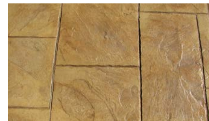
Per ultimo viene effettuato un trattamento con resina acrilica antiolio, che ne conferisce brillantezza e durata
