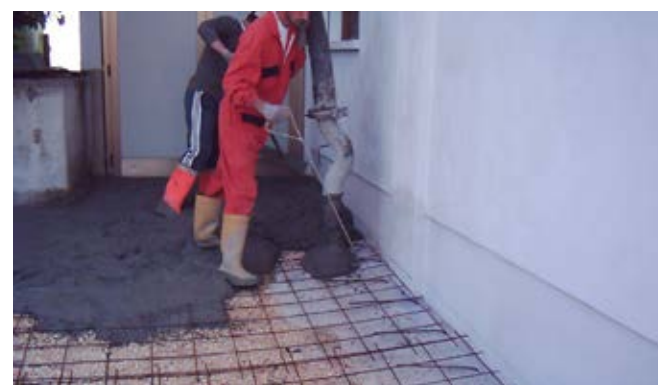
Stesura del calcestruzzo sul fondo ben compatto
