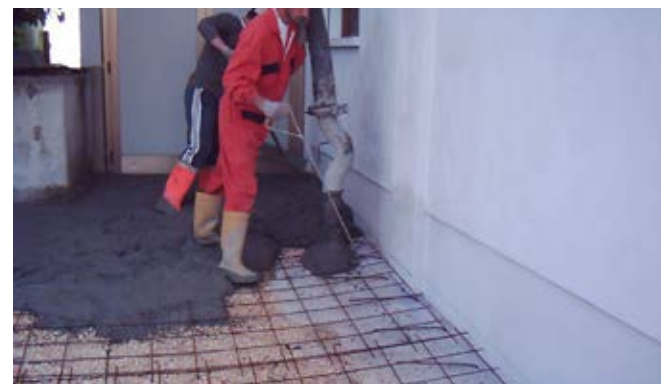
Stesura del calcestruzzo sul fondo ben compatto
